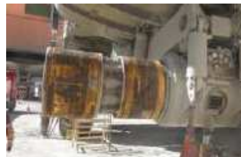
Desmontaje vertical, traseras interior y exterior
